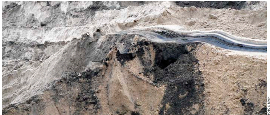
Verontreinigde bodem in Zutphen tijdens een sanering. De foto toont hoe heterogeen bodems verontreinigd kunnen zijn.
